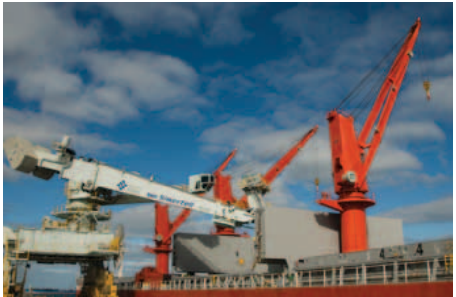
Siwertell unloader, Kwinana Bulk Jetty.
